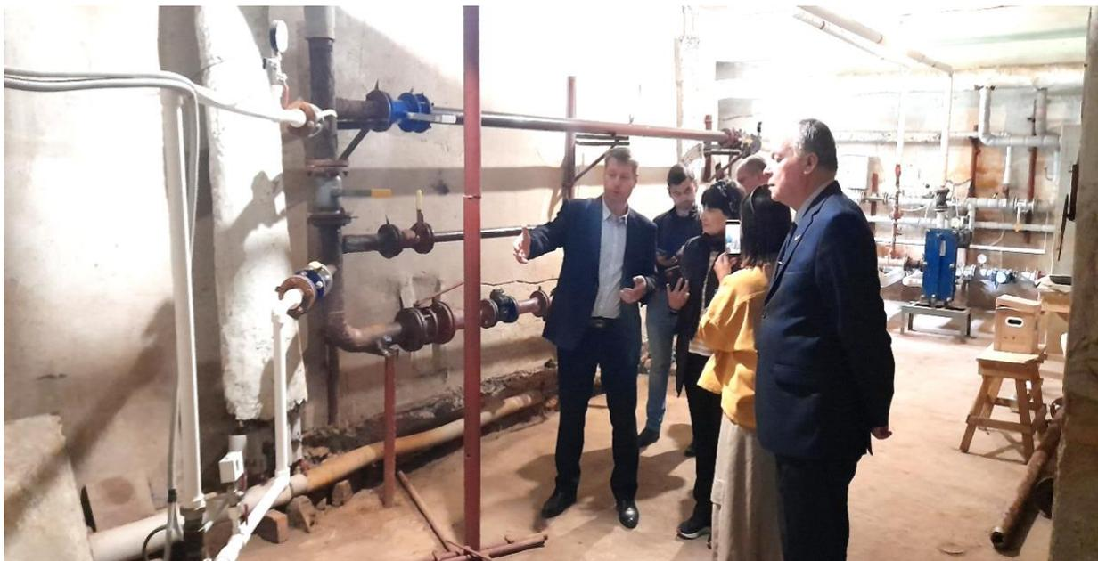
*Фото 3. Отремонтированный в рамках капитального ремонта тепловой узел в подвальном помещении МКД по ул. Октябрьская, д. 10. Фото ИЭГ*
