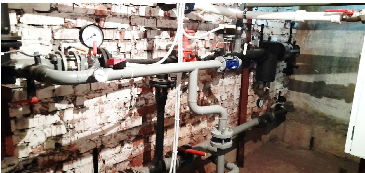
*Фото 5. МКД по ул. Любецкая, 13 – отремонтированный автоматизированный узел управления внутридомовыми системами горячего водоснабжения и отопления в подвале дома. Фото ИЭГ*
