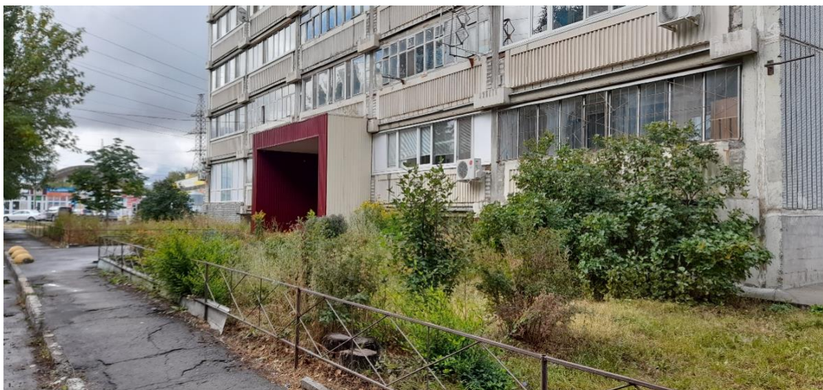
Фото 4 – 5. МКД по ул. Промышленная, 55. Фото ИЭГ
