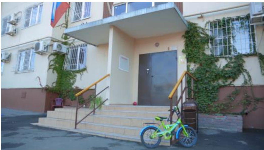
Фото 2. Входная группа в подъезд МКД после капитального ремонта. Фото ТСЖ «Башкирская-4»
