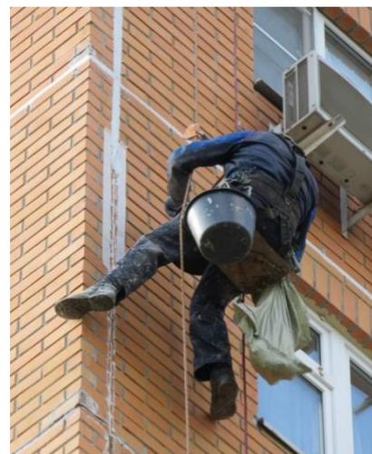
*Фото 3. Работы по герметизации межпанельных швов. Фото: Шиянов С. А.*
