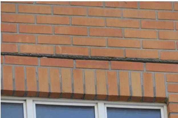
*Фото 2. На данном фото можно отметить плохое состояние межпанельных швов.
