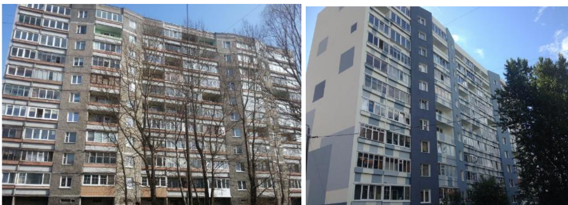
Фото 8-9. Дом № 18 по Солнечному бульвару (г. Калининград) до и после капитального ремонта. Источник: Фонд капремонта Калининградской области http://fkr39.ru/projects/sdannye-doma/g-kaliningrad-solnechnyy-bulvar-d-18/
