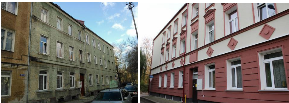
Фото 5-6. Дом № 20 по ул. Больничная (г. Калининград) до и после капитального ремонта. Источник: Фонд капремонта Калининградской области http://fkr39.ru/projects/sdannye-doma/g-kaliningrad-ul-bolnichnaya-d-20-ul-sibirskaya-d-25/
