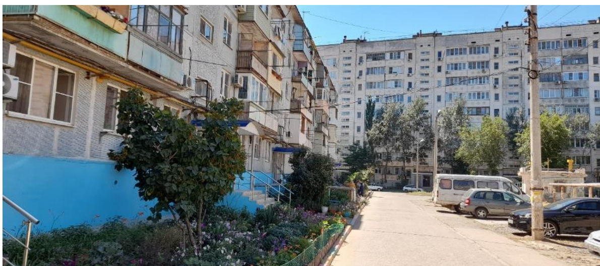
Фото 1 - 2. Общий вид МКД по ул. Куликова, 48, г. Астрахань. Фото ИЭГ
