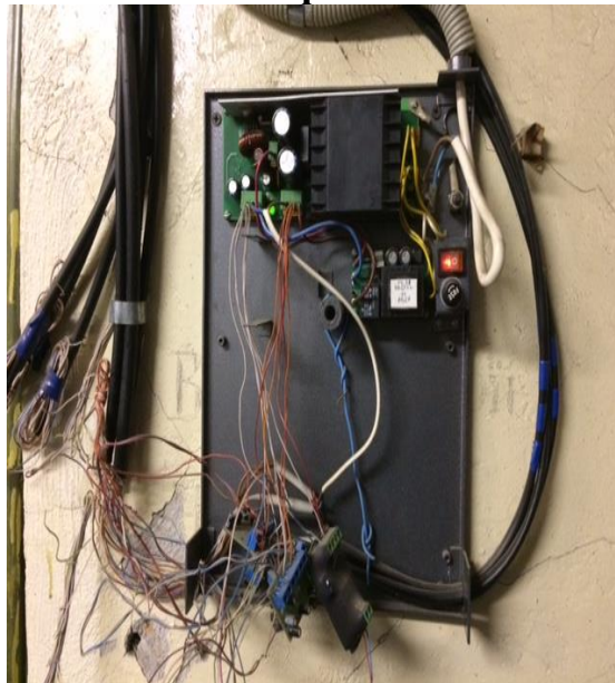
Блок коммутации голосой связи лифтов
