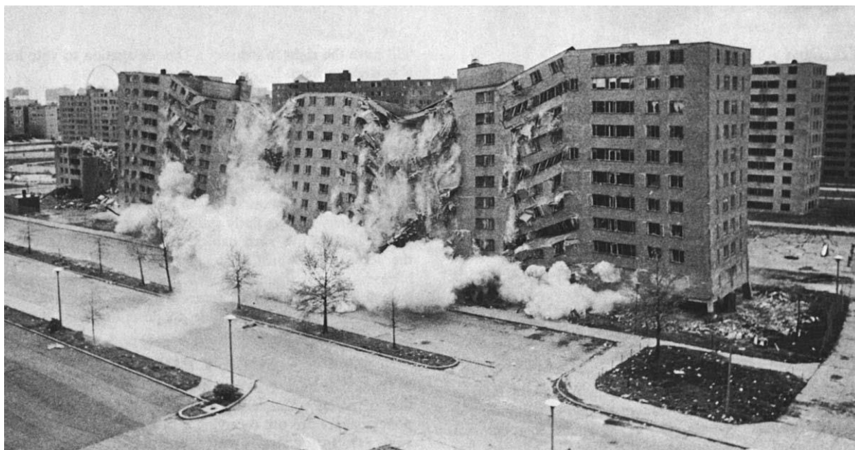
Рисунок 2 - Снос жилого комплекса Pruitt-Igoe (Сэйнт Луис, штат Миссури) 16 марта 1972 г., через 16 лет после строительства
