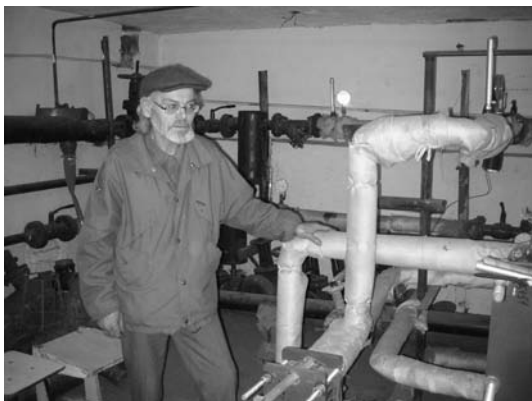
Реконструированный тепловой пункт в ТСЖ «Содружество», г.Пермь
