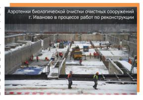
технология реализуется путём создания в аэротенках, наряду с аэробными зонами, анаэробных (без доступа кислорода)и аноксидных (с доступом химически связанного кислорода, поступающего с нитратными формами) зон. Одновременно достигается эффективная очистка стоков от органических веществ.
