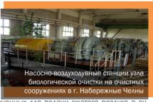
В насосно-воздуходувных станциях, предназначенных для подачи сжатого воздуха в систему аэрации аэротенков, произведена замена воздухонагнетателей. Запущенные в
