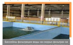
Промывные воды скорых фильтров возвращаются в «голову» сооружений на 1-ю ступень водоочистки рециркуляторов-осветлителей, что не только не снижает эффективность работы сооружений первой ступени очистки в основном технологическом процессе, но и способствует улучшению протекания процессов коагуляции.
