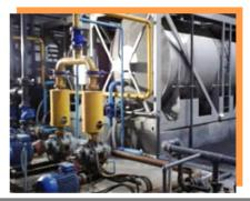
Установка сорбционной обработки воды порошкообразным активированным углем на сооружениях водоподготовки в г. Череповце
