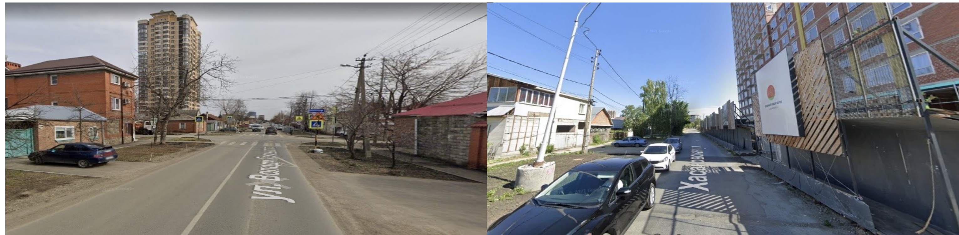
Иллюстрация точечного размещения высотных многоквартирных домов в ареалах малоэтажной жилой застройки (Краснодарская и Екатеринбургская агломерации)
