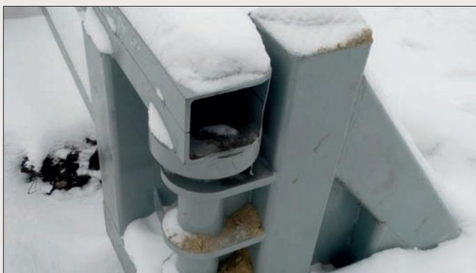
Рис. 1. Поворотный шлагбаум с пустотелой стрелой, сваренной из двух швеллеров
