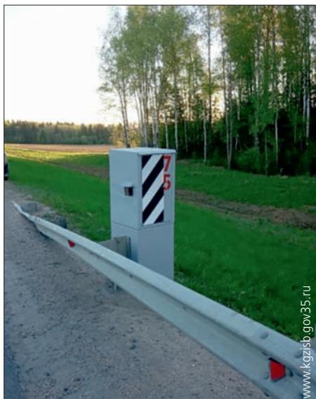
Вандализозащитный бокс для размещения передвижного комплекса
