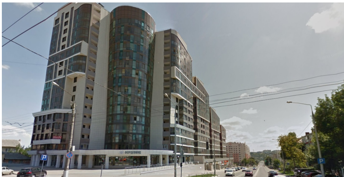
Рисунок 26 - Пример реализованного проекта, заявленного в качестве проекта РЗТ. Ул. Белгородского полка, 72 110
