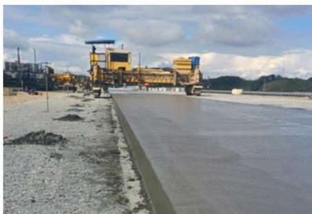
площади были выполнены работы по комплексному устройству армированного монолитного цементобетонного покрытия.
